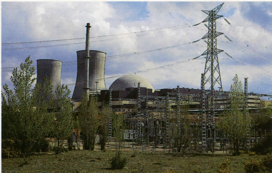
La paralización de Trillo no pondría en peligro el suministro de energía eléctrica, ya que el parque eléctrico puede prescindir de los 1.100 MW de dicha central. Foto: Gaia
