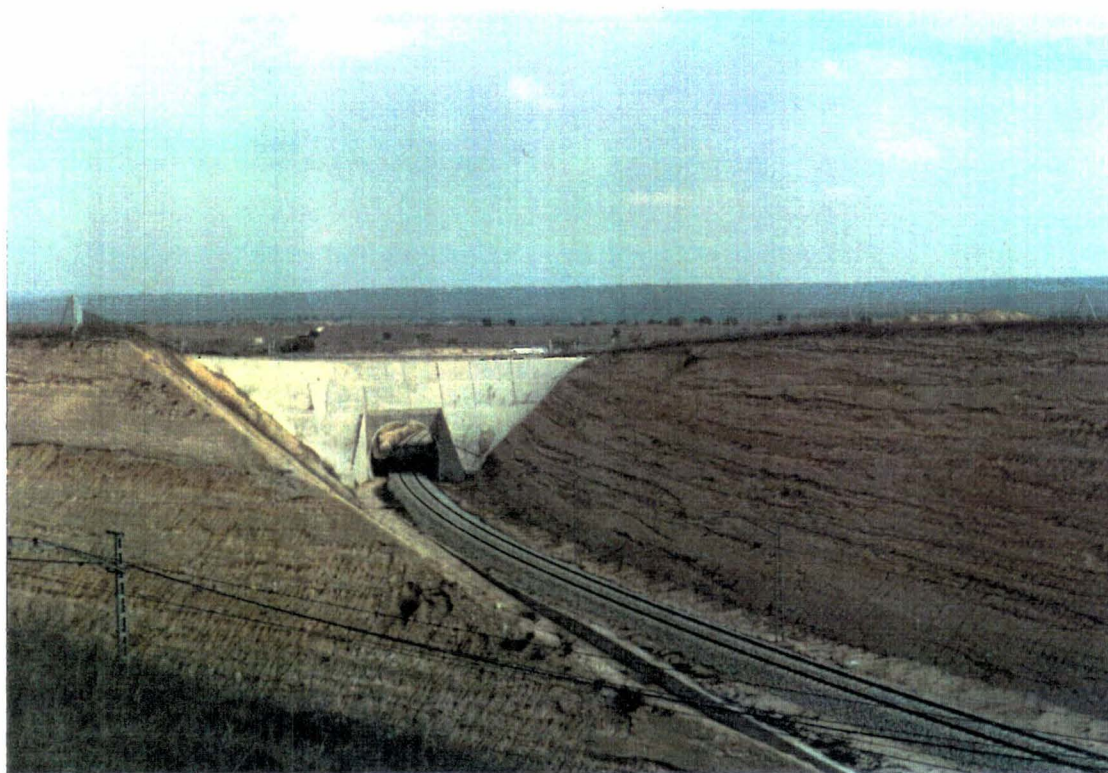
Foto nº 1. Obras de la RENFE en el Garzo.
