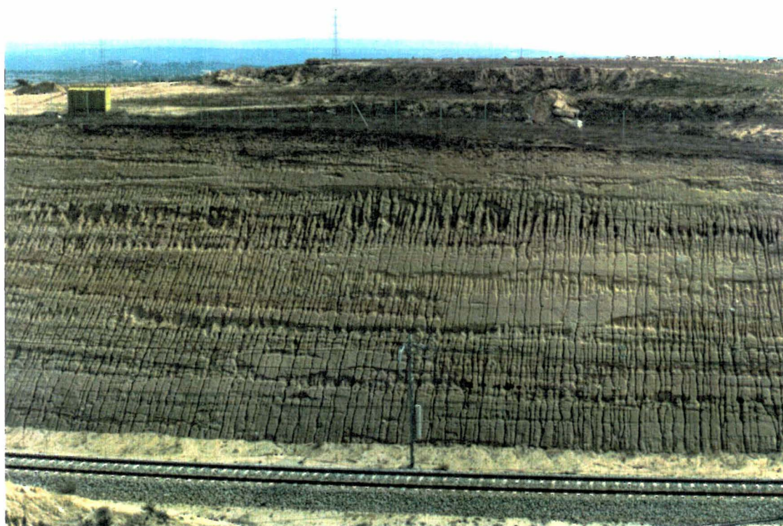
Foto nº 2. Obras de la RENFE en el Garzo. Detalle del talud.
