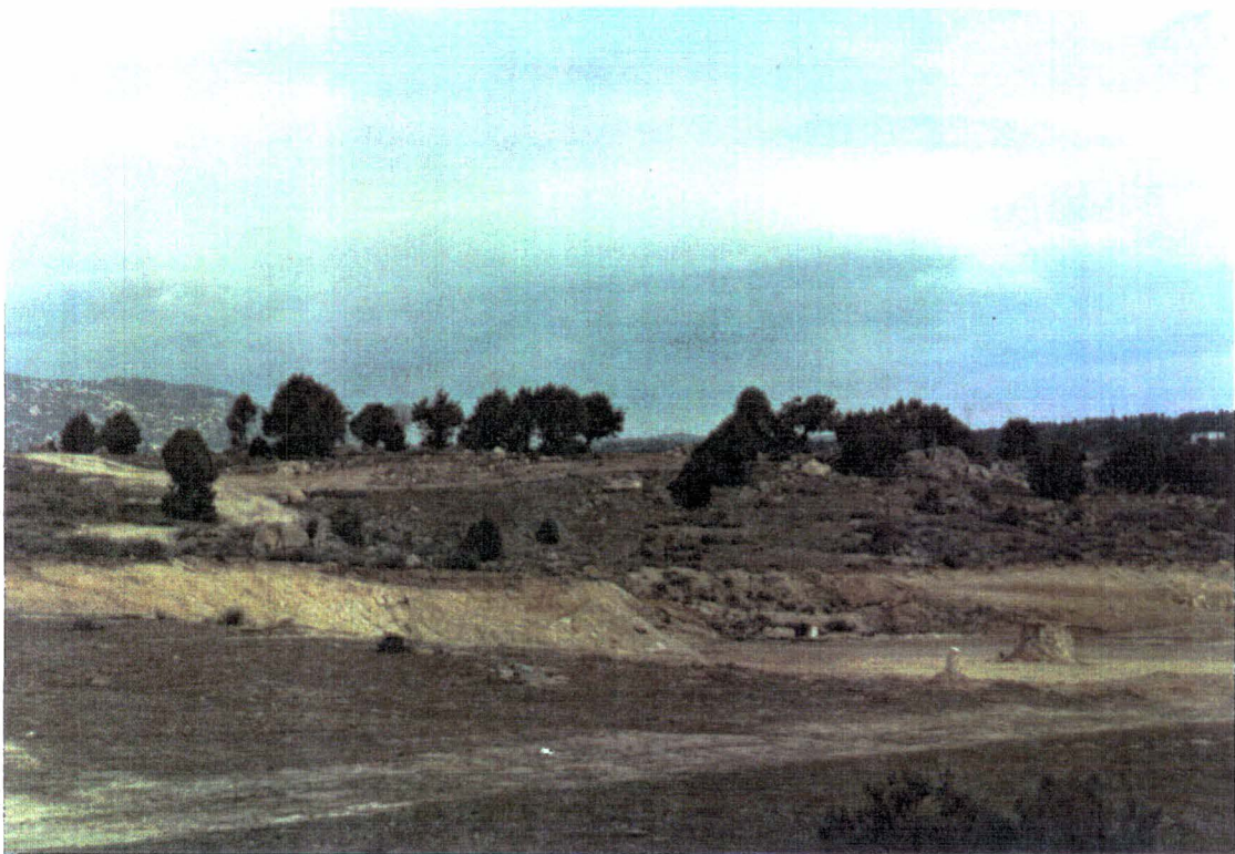
Foto nº 3. Obras ilegales de urbanización en Hoyo de Manzanares.
