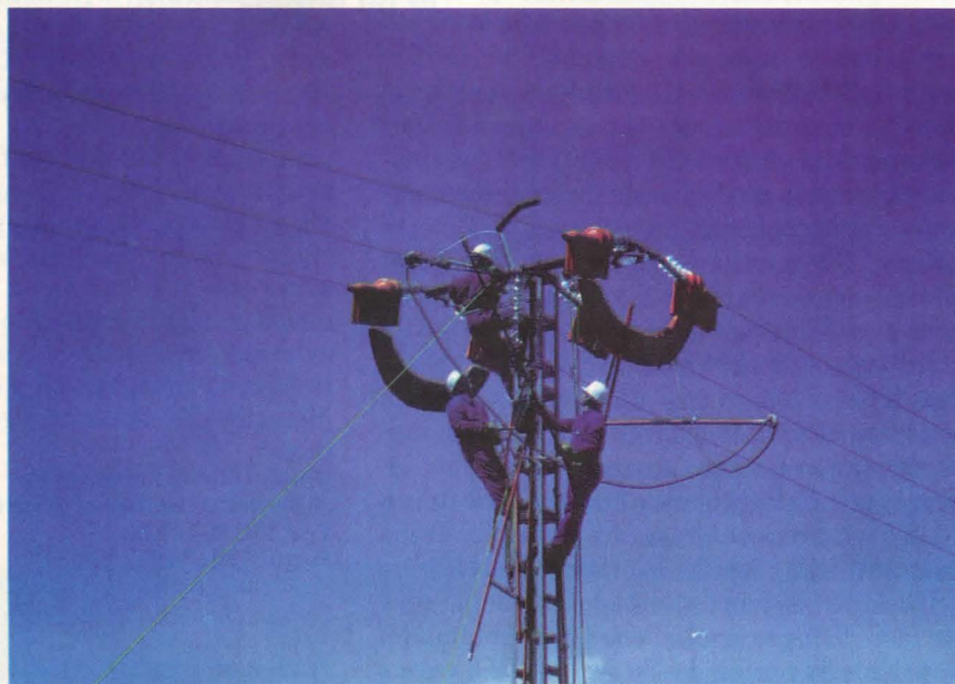
Trabajos de Iberdrola para la corrección de tendido eléctrico.
